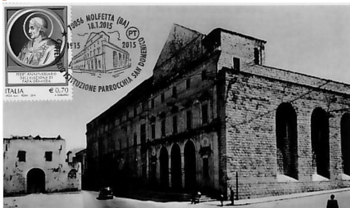
3 - Le facciate della Chiesa negli anni '50 (da notare l'assenza dei palazzi)
